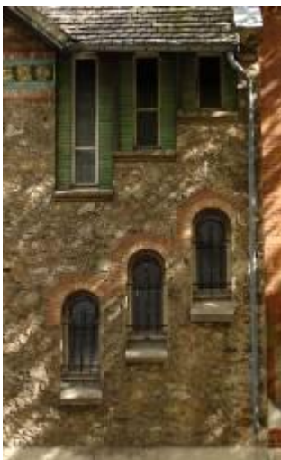
8. Détail de la façade de l'hôtel Jassédé rue Chardon-Lagache
