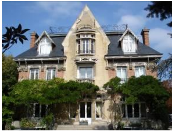
La Hublotière : façade principale
