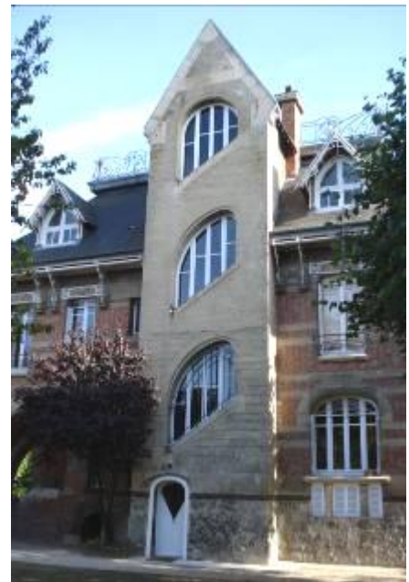
10. Travée abritant la cage d'escalier de la Hublotière
