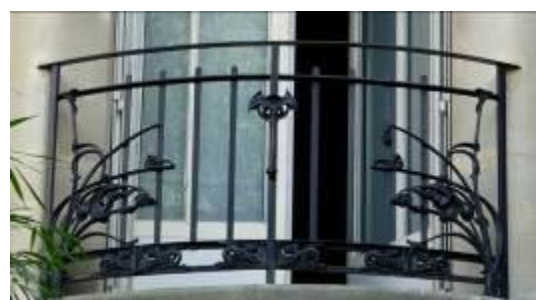
19. Balustrade de l'hôtel Deron-Levent
