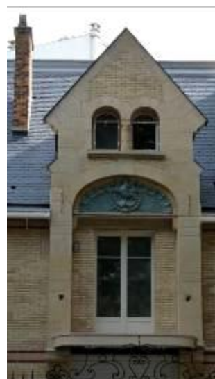
5. Détail de la façade de l'hôtel Delfau, rue Molitor
