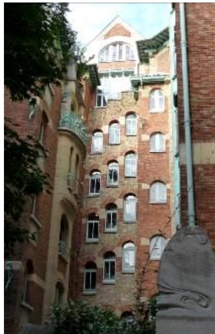
9. Corps de bâtiment accueillant l'escalier au Castel Béranger
